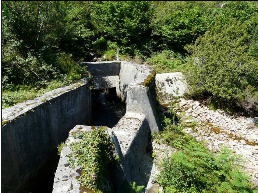
Figura 3. El agua de los arroyos que descenden de Peña Sagra es captada y desviada hacia los canales que alimentan las centrales eléctricas. En la imagen, desvío del agua del Bco. de la Yunca en Joyoprao (Rionansa).
